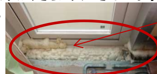
測定前には隙間を埋めるため、しっかりと吹き付けを行っています
